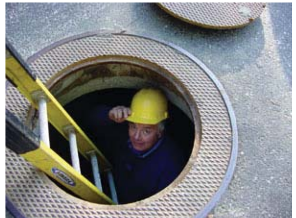
Fotografía de un ensamblador de cable ingresando a una alcantarilla, cortesía del lugar de la red de la ciudad de Wellesley, Massachusetts en el http://wellesleyma.virtual-townhall.net .
